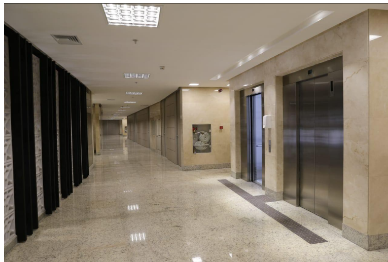
Figura 5.6 - Portas do Ascensor 1 e Ascensor 2 no Fórum Dr. Heitor Moraes Fleury.
